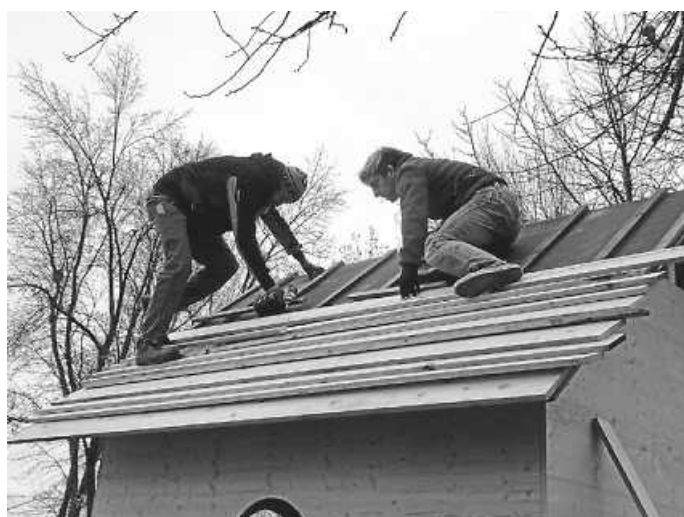
Die Papas beim „Dachdecken“ des Spielhauses
