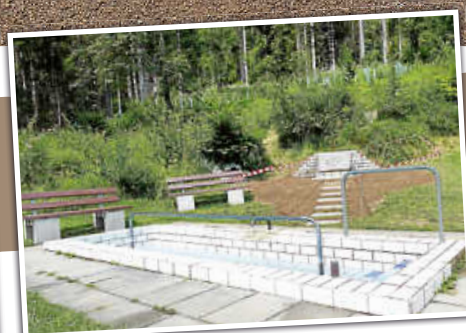
Wassertretanlage OT Horgen
