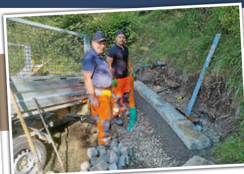
Das Bauhofteam im Einsatz.
