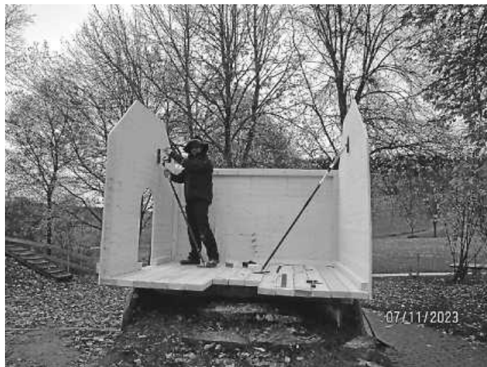
Josef Flaig beim Erstellen des Grundgerüsts
