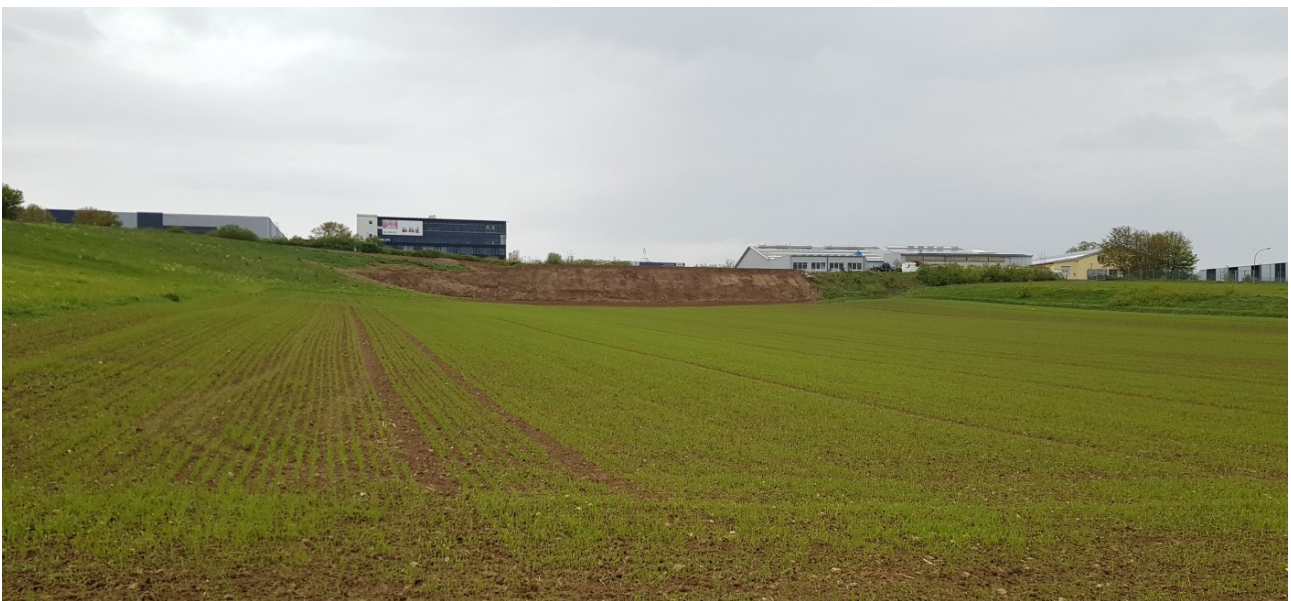
Abb. 5: Anhand des Offenbodenhangs erkennbare Auffüllung der Senke, oberhalb des rechten Hangebereichs sind die Bestandsgebäude des Betriebes sichtbar
