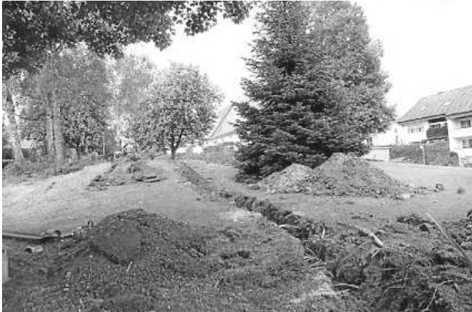
Erd- und Kabelarbeiten für Stromanschluss Festbetrieb Alois-Mager-Platz
