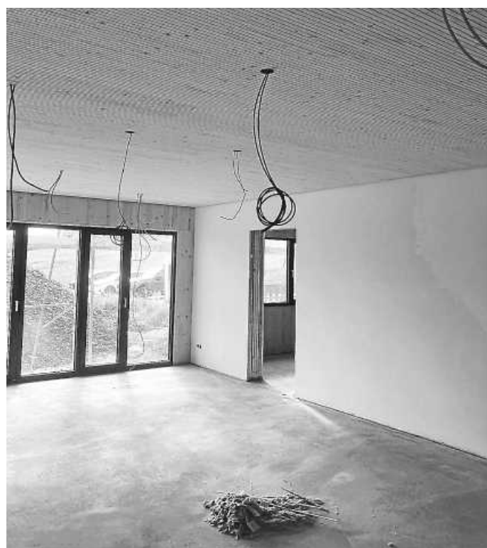
Derzeit erfolgt der Einbau der Lärmschutzdecken Foto: Georg Kunz
