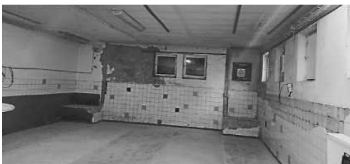
Der Raum vor Beginn der Bauarbeiten
