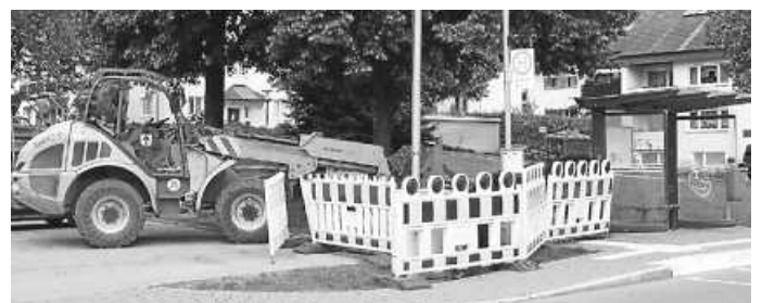
Erd- und Kabelarbeiten für Ladesäule E-Carsharing
